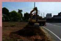
作業風景(新田前遺跡11区)
