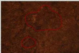
炉跡(赤線内側) 炉跡は使用時の熱によって赤褐色に変色している。
