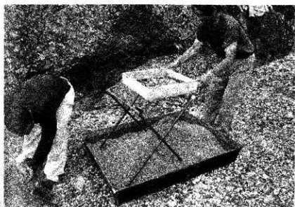
75 工事中 左官工事 同上、白柱下の江海岸にて（上記蒲江の砂とブレンドして使用する）
