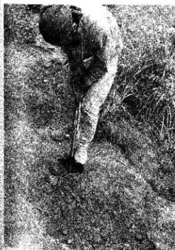
76 工事中 左官工事 赤色土の採取 佐伯市波蔵地区で
