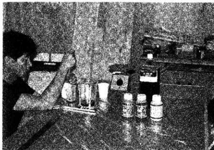
62 工事中 古色調合 既存木部に合せて調合した
