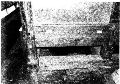
106 現状変更資料 覆間外部（は）通りに残る足固め 等の痕跡と土台層に残る根太掘り 痕跡。延長されていた
