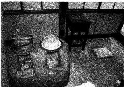
81 工事中 左官工事 台所内釜戸完成 土間は三和土叩きで仕上る
