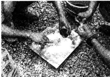
77 工事中 左官工事 しっくい試験練り
