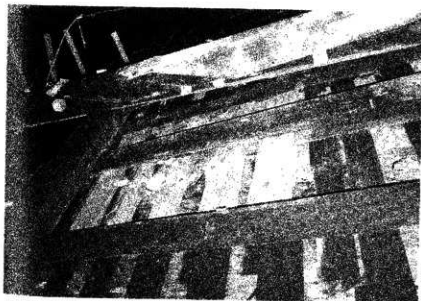
100 現状変更資料 台所屋根野地 腰壁根を除去した跡 新しい杉板で塞がれていた
