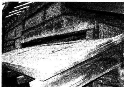
104 現状変更資料 備間外縁上部に残る庇 当初の玄関庇が解る
