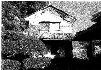
121 修理前 土蔵 正面（南）外觀
