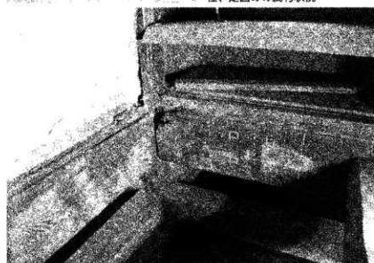
93 破損状況 柱、足固めの腐朽状況
