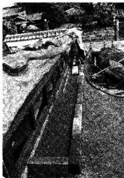
85 工事中 外構 庭板塀前のスロープ用布礎石
