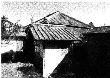
31 修理前 同上、手前は風呂場棟
