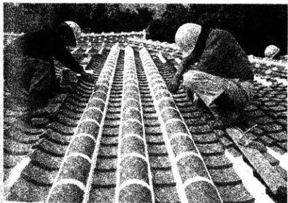
70 工事中 屋根工事 目詰めしっくい最後の仕上
