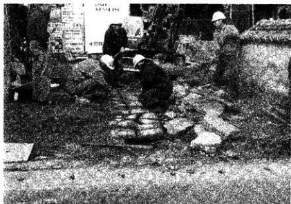
87 工事中 庭工事 進入口仮いの整備
