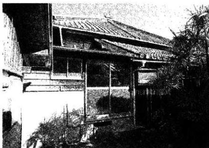
30 修理前 南面外観
