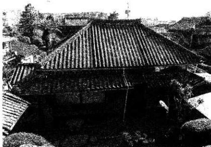
29 修理前 （西面） 背面全景
