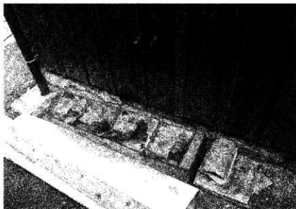
83 工事中 外構 台所外部の排水路と縦樋掛
