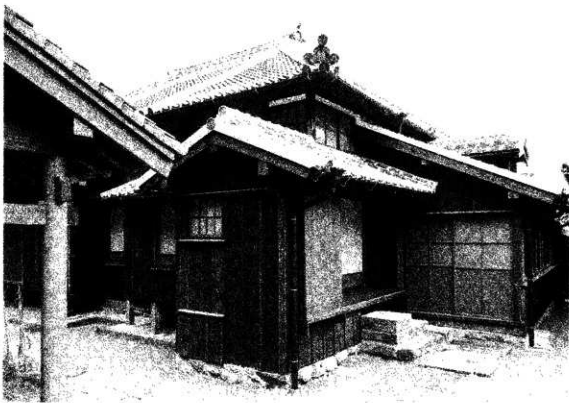
2 竣工 南西面 台所出入口附近
