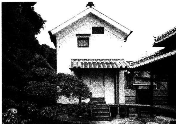
15 竣工 外觀正面
