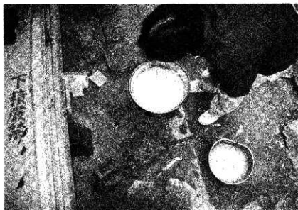
78 工事中 左官工事 罎用のワラビノリを炊く
