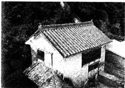
123 修理前 土蔵 外觀 屋根面
