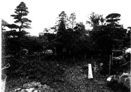
88 工事中 庭工事
