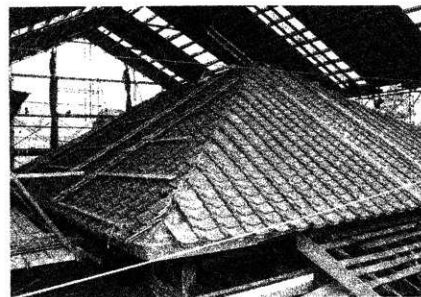
67 工事中 屋根工事 棧瓦の葺き上がり
