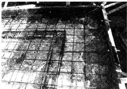
131 工事中 土蔵 同 上 土間コンの鉄筋組み
