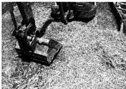
51 工事中 土 拵 え 再生土に切りワラを混入する
