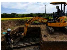
写真125 T4表土掘削状況
