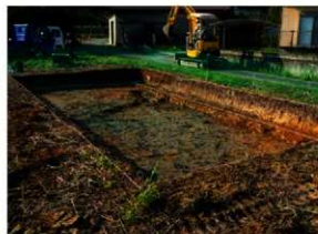
写真34 表土・耕作土除去状況(南西から)
