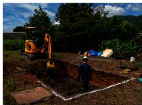
写真170 表土掘削状況(東南から)
