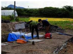
写真148 T4排水作業
