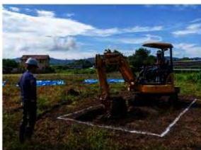
写真169 表土掘削状況(東から)
