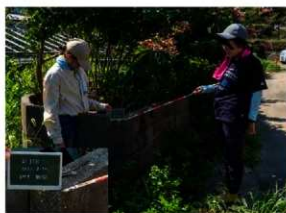
写真108 BM9設置状況(南から)
