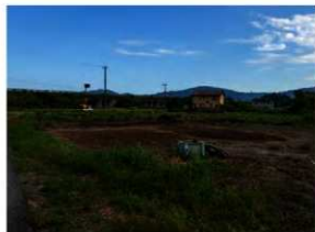
写真81 埋め戻し完了状況(北から)
