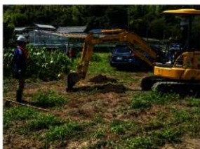
写真123 T5表土掘削状況
