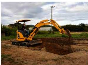
写真161 T4埋め戻し状況
