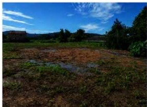
写真190 埋め戻し完了状況
