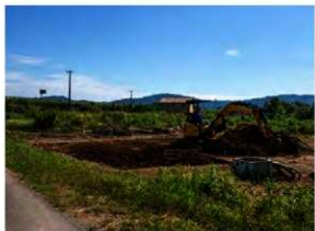
写真80 埋め戻し状況(北から)
