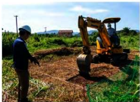
写真87 重機掘削状況(北から)
