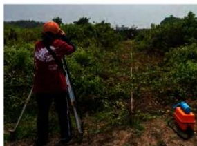
写真23 予備調査風景
