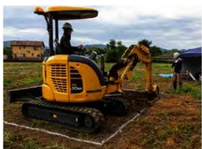
写真124 T4表土掘削状況
