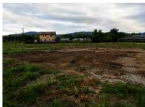
写真162 埋め戻し完了状況
