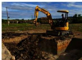
写真160 T4埋め戻し状況
