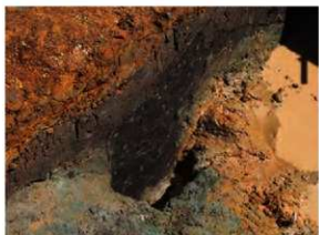
写真60 T2-P1 半掘状況(南西から)
