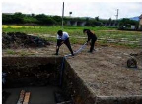
写真147 T4排水作業
