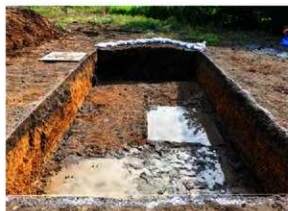
写真172 表土除去状況(東から)
