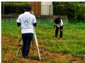
写真121 調査坑設置作業
