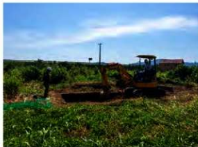
写真88 重機掘削状況(北から)
