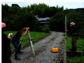
写真1 子備調査作業風景
