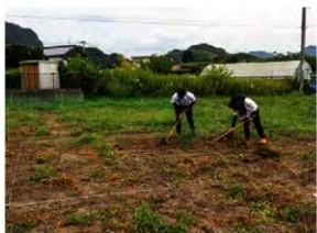
写真122 T4調査坑設置作業
