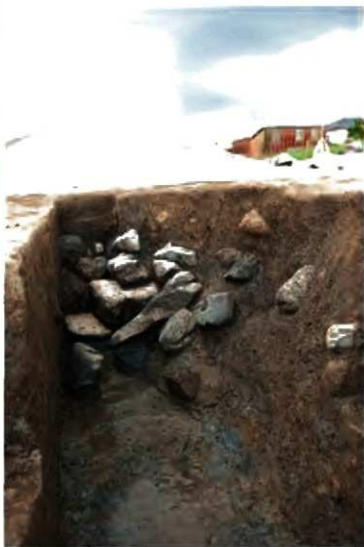
西側柱列南端の礎石据付穴に詰められた礎石(北から)
