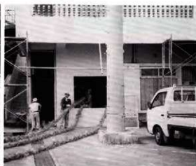
写真 2-4 完成した綱の収納の様子
