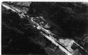
平成7年度調査終了全景 E→
