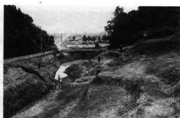
E 区南側段築状況 N→
