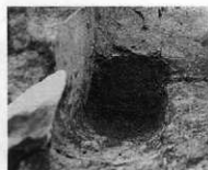
煙道部横断面 (西から)
