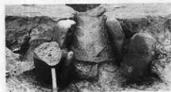
カマド袖石及び袖部断面
