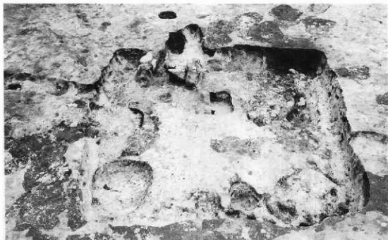
完損全景（北から）
