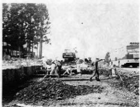
南区捨て場(掘り上がり)
