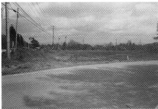
ⅠA・ⅠB区近景(西から)
