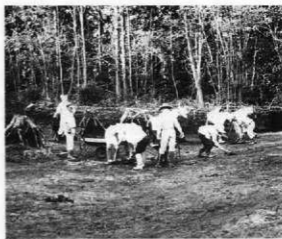
I D区作業風景
