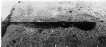
2号罐道埋土断面
