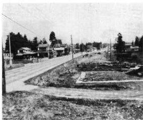
北側区域調査前(南から)
