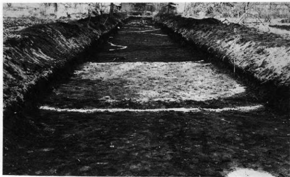
a. 試掘調査状況
