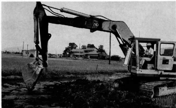
A・重機による粗掘り作業
