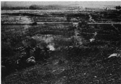
A. 遺跡の前面と作業状況
