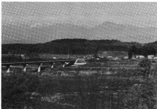
A. 遺跡遠景（工事完了後）
