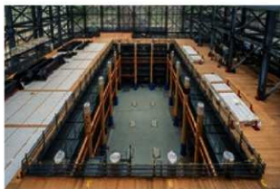
図57 東楼側柱建方 東楼棟通りを中心とした全景 （2023年9月7日撮影・東から）
