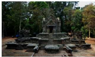
図17 三祠堂修復後（東から）
