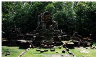
図15 三祠堂修復前(東から)
