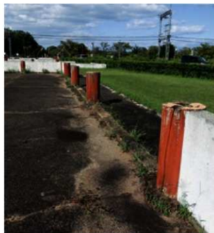
図62 修繕工事前の兵部省（南から）
