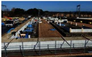
図66 修繕工事中の呉部省（南から）
