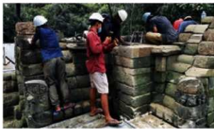
図16 中央祠堂再構築作業風景（北東から）
