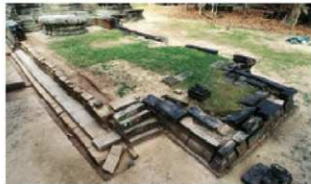
図19 東テラス南壁修復中（南東から）
