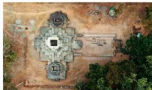
図14 三祠堂修復後の俯写真(上空から、上が北)
