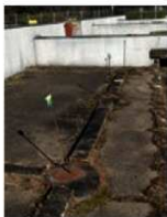
図63 木柱撤去後の回廊（南から）
