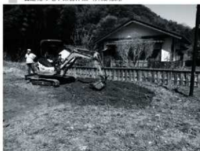
石造物の地中保管作業完了状況（拝殿北側）
