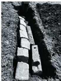
石造物の地中保管作業（拝殿北側）
