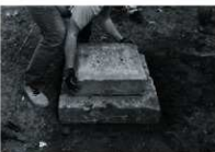
2 上段基礎の設置
