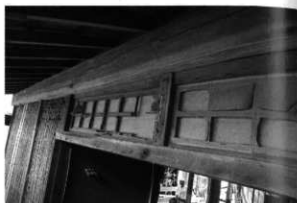
北エン後補修理外壁除去（ランマ障子内蔵）
