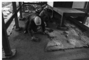
雑工事 三和土叩き
