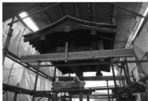
三府御門 支柱を取り屋根を浮かせた
