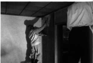
左官工事 中塗り
