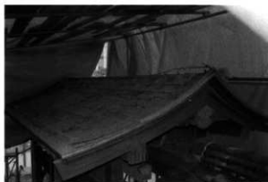
三府御門 屋根瓦除去
