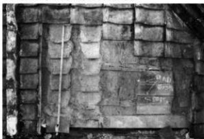
瓦下地技法 野地板より瓦葺替え有り
