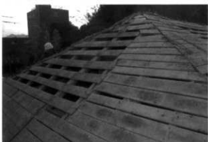
屋根野地板 小間返しは当初 ベタ貼は修理部
