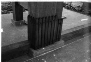
三府御門 柱脚寄巻組立
