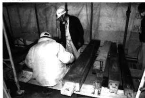
三府御門 現況柱の調査
