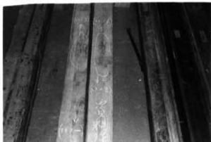
墨書 (い) 通り足固め横面に【廊下部】
