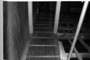
南エン現況床及び御居間床板除去
