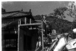
曳き移転に先立ち渡り廊下部の分解
