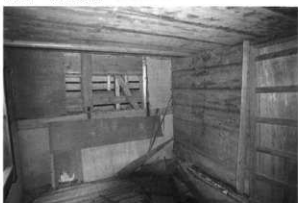
内部 1階西室軸部に筋違
