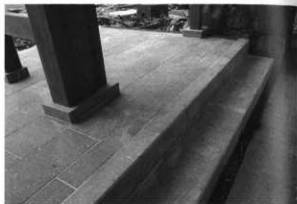
三府御門 正面石階設置
