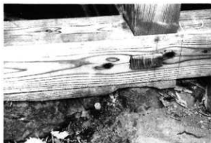
木部加工土台下養生栗板を入れる
