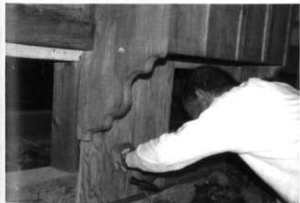
木工事 腰板取付け
