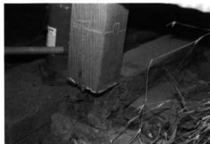
ぬノ八柱脚土台欠損 十文字目違継指示
