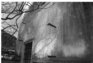
妻壁に在る掛庇支柱用の金具
