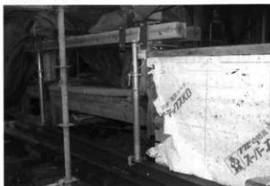
建物移動中 渡り廊下部除去
