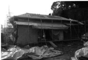
屋根瓦の除去
