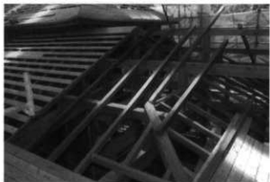
木工事 北面屋根増築部
