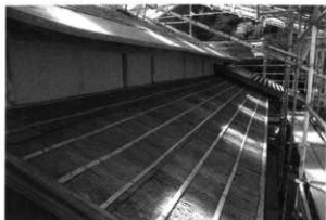
屋根工事 杉皮下地施工
