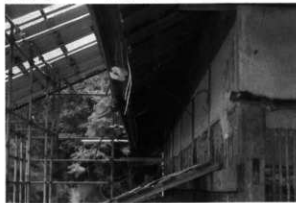
野地及び上壁除去
