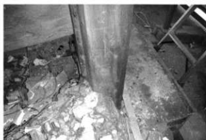
三府御門 柱脚部解体
