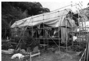
移転前の仮設シート養生
