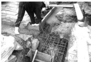
基礎地中梁 配筋 コンクリート打設
