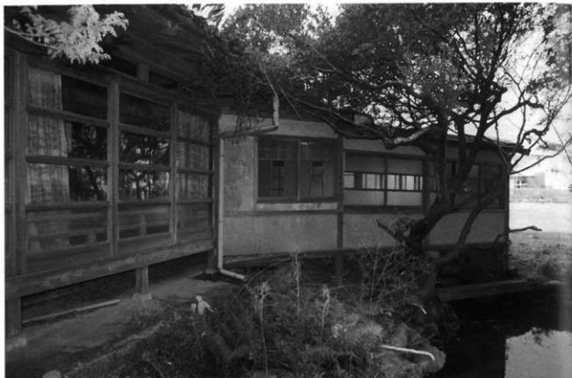
外観 南面から渡り廊下
