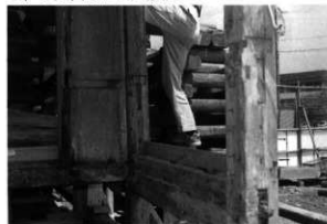
(は) 通り(一)~(二)間戸袋痕跡と腰窓敷居の痕跡
