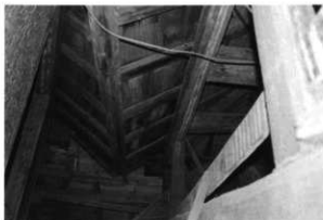
広間と御居間屋根接合 桁と貫に土壁痕跡
