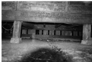
北エン床下部 床下換気孔連子
