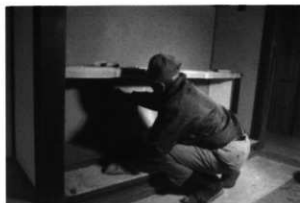
左官工事 仕上塗り
