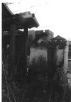
三府御門 同左 (支柱と控柱をボルトで緊結)
