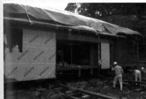
曳き移転準備 外壁モルタル除去
