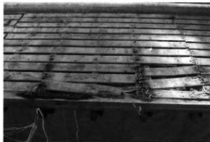
野地板タルキ部の欠損
