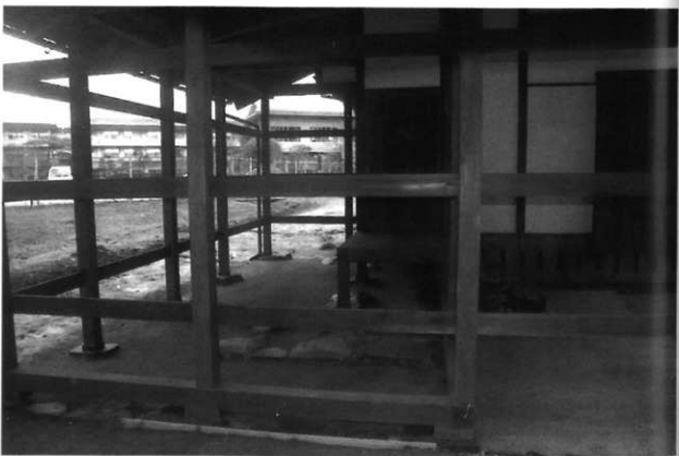
外観 西面増築部
