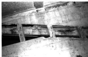
御化粧間 当初足固め柱 (七番) 切断 広間廊下下に残る
