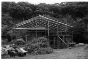
仮設工事 外部足場と素屋根掛け
