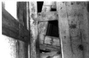
御化粧間 南西間広間廊下下に残る切断柱 (又七) と足固めに雨戸数居
