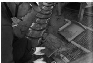
屋根 谷瓦葺き
