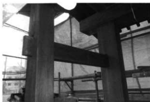
三府御門 主支柱組立据付
