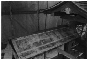
三府御門 脇門 屋根下地
