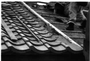
屋根 瓦葺き 一筋土置きで葺く
