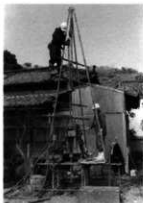
ボーリング調査
