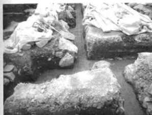
写真5 地中梁捨コン打設
