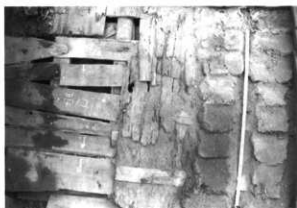
写真22 本建部 野地板「オガ引き・帯ノコ」
