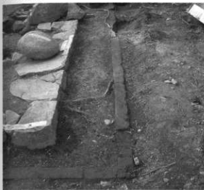
写真9 葛石検出状況（北側）
