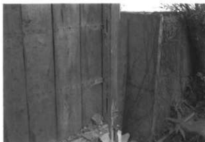
写真20 (いノ五) 柱 貫・間渡し痕跡
