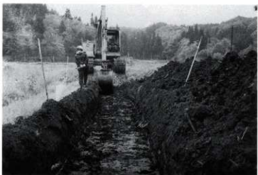
工事立ち会い状況
