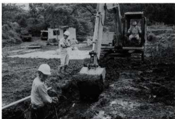
工事立ち会い状況
