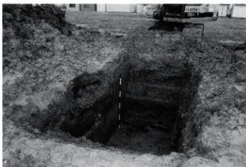
1トレンチ完掘状況 西から
