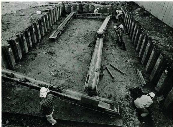
人力掘削風景
