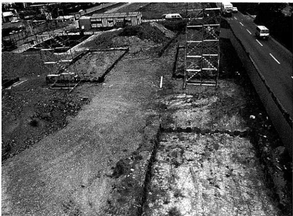
調査地 13B~15B 全景（北から）
