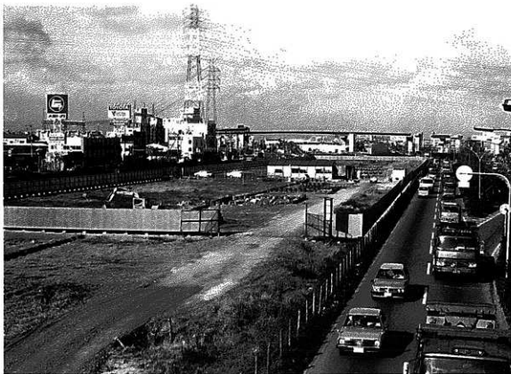
調査地全景（南から）
