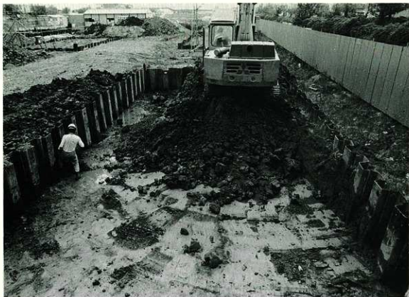
機械掘削風景
