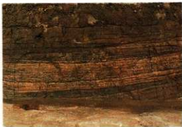
深迫門礎検出の版築土壘 (厚さ5～10cmの粘土を叩き締めながら積み上げたもの)
