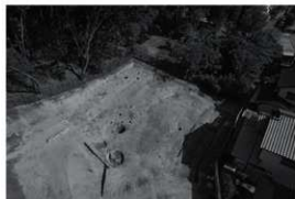
2. 調査地東半部全景 (南から)
