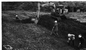
調査風景（重機作業）
