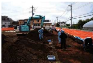
2. 表土剥ぎ (北東から)
