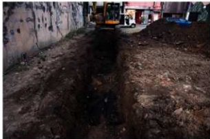
(1) II区西側トレンチ掘削状況(南西から)
