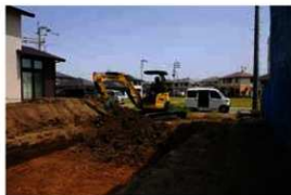
第56図 表土剥ぎ風景(北から)
