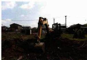
第8図 表土剥ぎ風景（西から）
