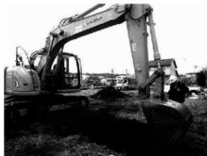
写真2 重機による表土除去作業
