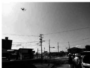
写真4 ドローンによる空中撮影
