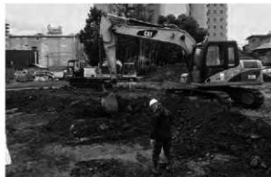
写真2 重機による表土除去作業
