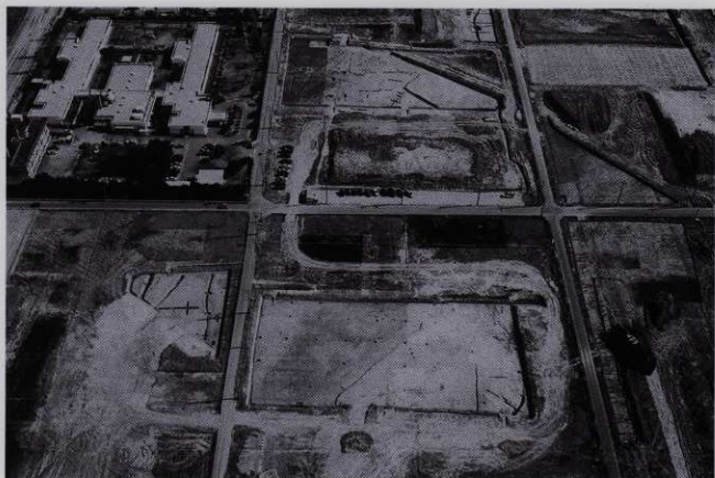
A区・B区全景
