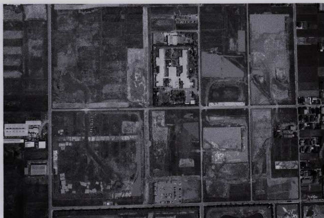
17地点全景 (D·E区)
