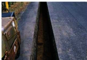
第57図 D区南部検出状況（南から）
