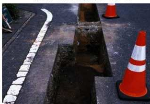
第54図 C区中央部検出状況（北から）
