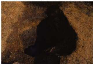
第18図 SP5掘削状況 (南西から)
