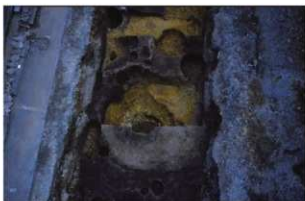
第22図 SE 62掘削状況 (北から)
