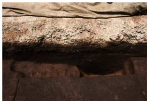
第 83 図 SD4・5 土層断面 (東から)
