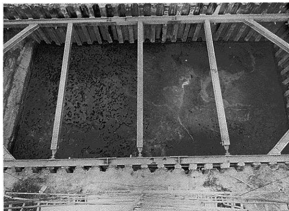
1Bトレンチ 足跡掘削状況(東から)
