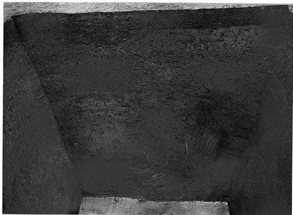
I・II層 3Aトレンチ マス掘り東側断面(西から) (中央付近から上サンドパイプ。)
