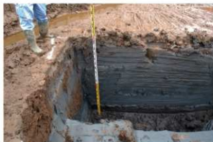
調査区北部深掘トレンチ
