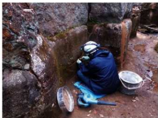
ひび割れ修理
