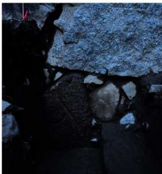
石垣地中部分の状況（西から）
