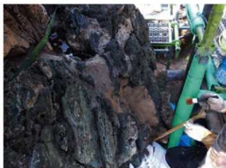
景石の保存修理
