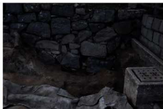
石積み下部石列検出状況（北から）
