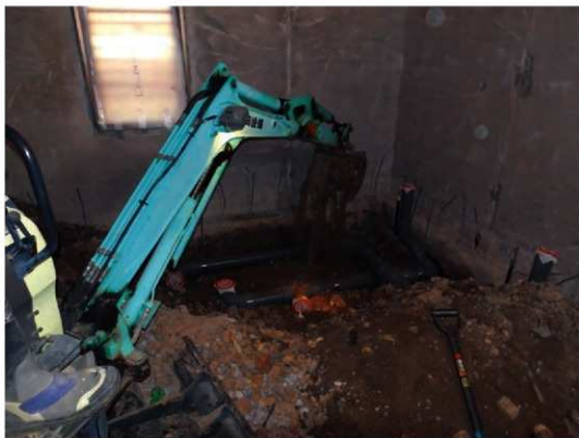
新規掘削立会写真
