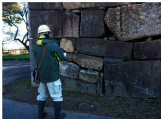
現地調査の様子（123H石垣）
