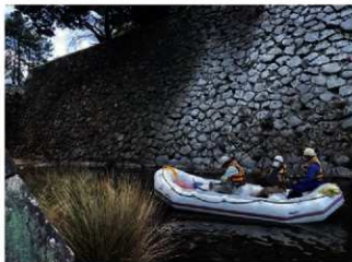
現地調査の様子（水堀部）
