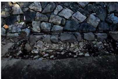
調査区イ 突出部（写真右側）より連なる石垣（西から）
