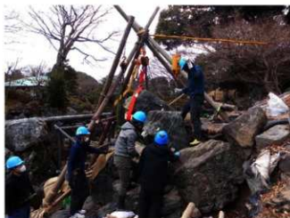
石の据え直し
