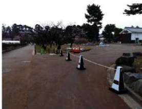
搬出入口付近施工完了風景
