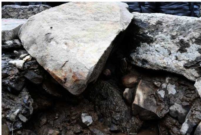
北側トレンチ逆石の下部築石状況
