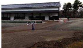
展示収蔵施設付近施工完了風景
