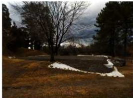
土台造成完了時
