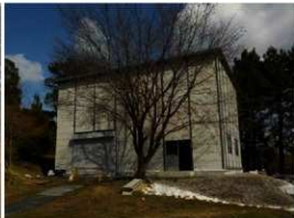
仮設作業小屋設置完了時
