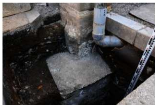
門小屋根控柱の掘削状況(北東から)
