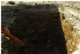
樹の掘削状況
