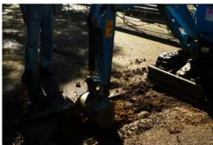
配管工事の掘削状況(北から)
