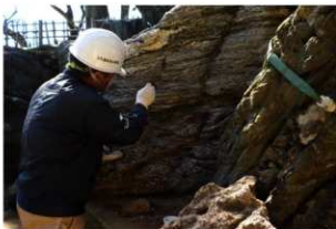
石組の保存修理
