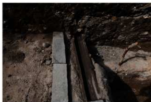
7トレンチ 角形半径土管（南から）
