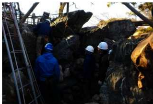
景石の据え直し
