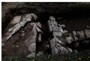
10トレンチ北側 溝（西から）
