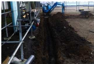
掘削の完了(北から)
