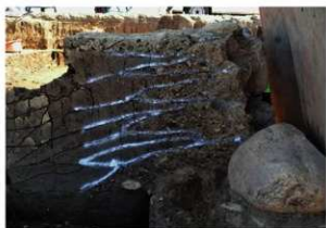
7号古墳 玄室奥壁裏込め断面
