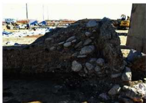
4号古墳 玄室奥壁裏込め断面
