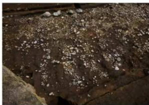
7区 1号道路状遺構2面波板状凹凸面（南から）
