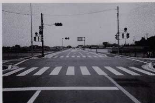
A区現況(北から)
