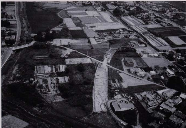
一面全景(北から 手前よりA・B・C区)
