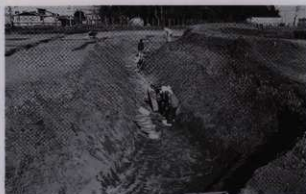
第2号溝跡 (東から)
