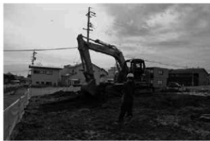
写真1 表土掘削 (4月5日)
