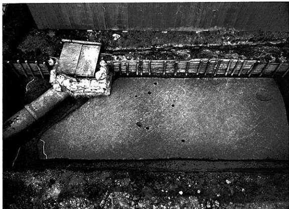
C-1 調査区 (南西より)
